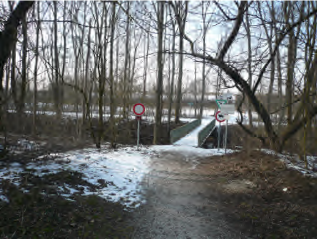
Fußgängerbrücke an das Isarufer
