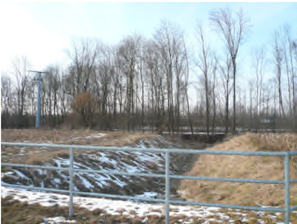
Graben mit Geländer, Blickrichtung Isar (Norden)
