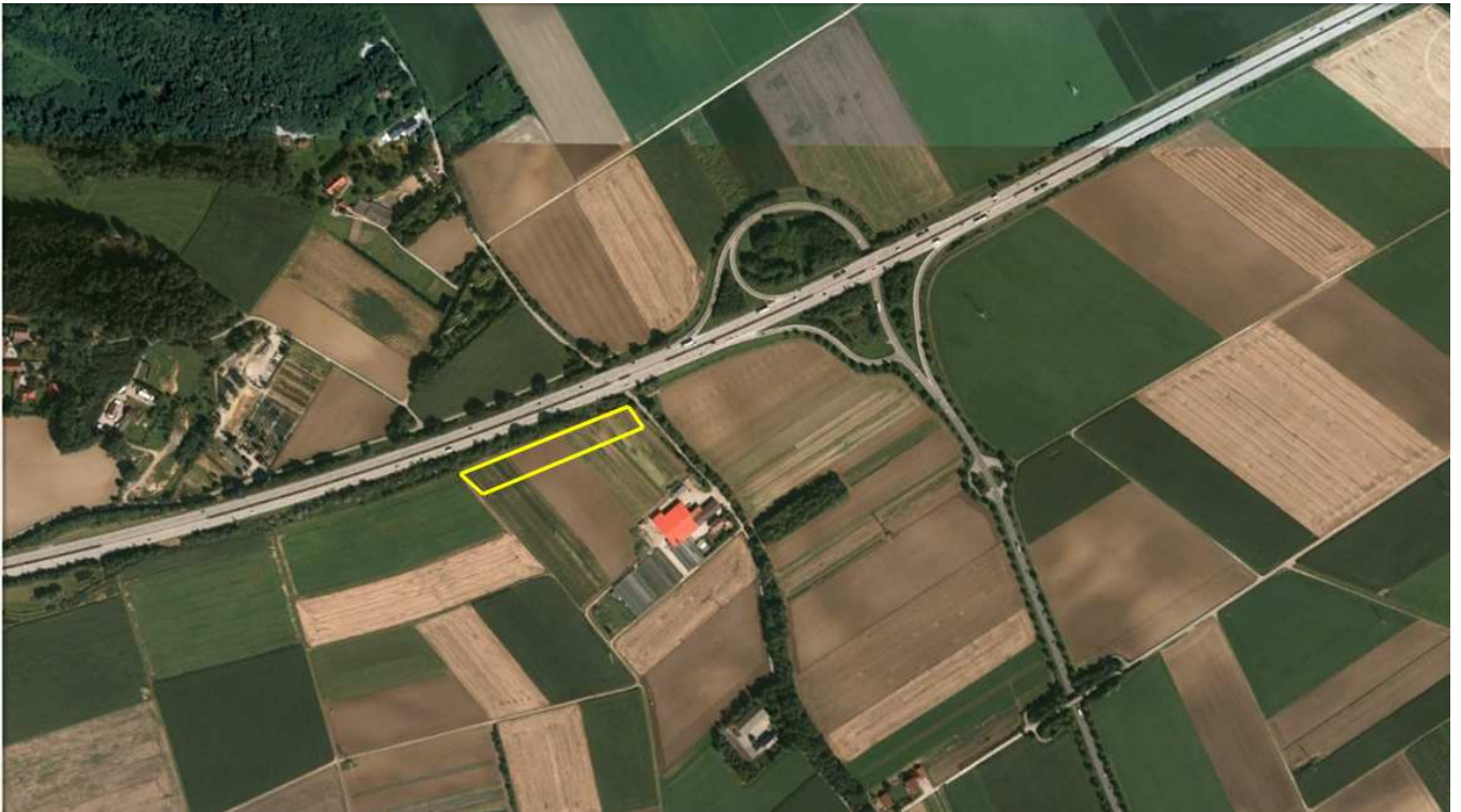
Bepanter Bereich PV-Anlage
