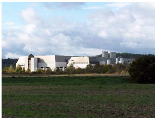
Blick nach Nordwesten
