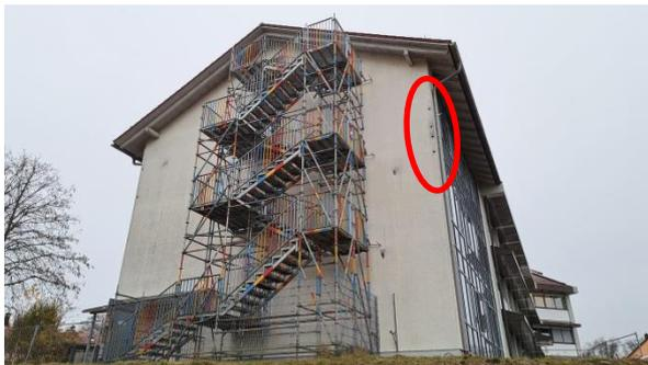
**Abb. 13** Nördliche Fassadenseite mit möglicherweise vom Specht aufgemeißelten Löchern
