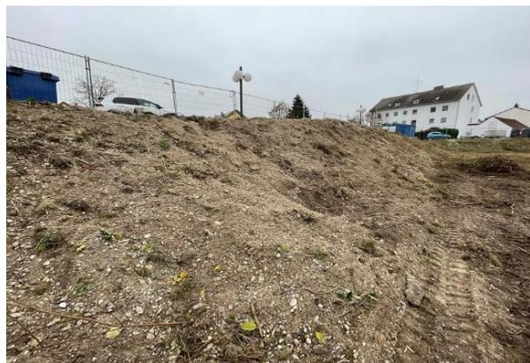
**Abb. 22** Böschung Südseite, entbuscht, Wurzelstöcke herausgerissen
