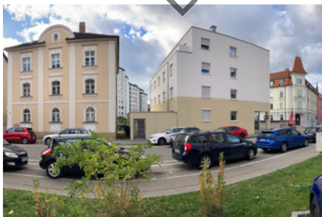
Beispiel eines sich städtebaulich nicht einfügenden Funktionsbaus in der Nikolastraße
