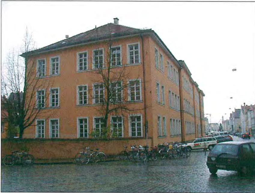
Foto 1 Ansicht Schulgebäude von der Neustadt aus (Blickrichtung Nord-West)
