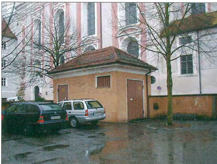
Foto 4 Ansicht Trafohäuschen vom Pausenhof aus (Blickrichtung Süd-Ost)
