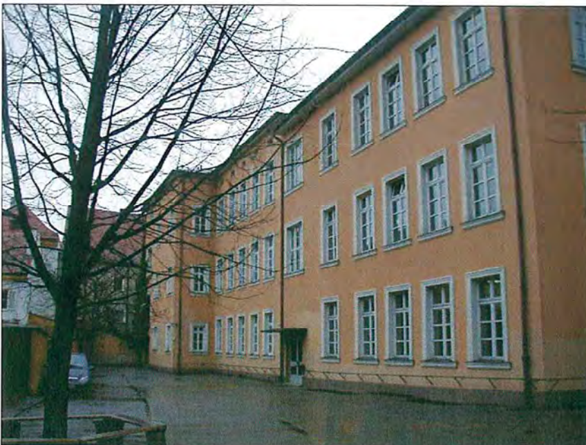
Foto 2 Ansicht Schulgebäude vom Pausenhof aus (Blickrichtung Nord-Ost)
