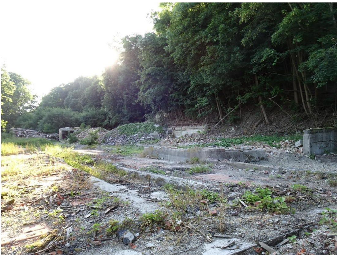
Abb. 3: Blick in Richtung Osten auf das UG und die angrenzenden Isarhangleiten (Foto: 09.05.2023)
