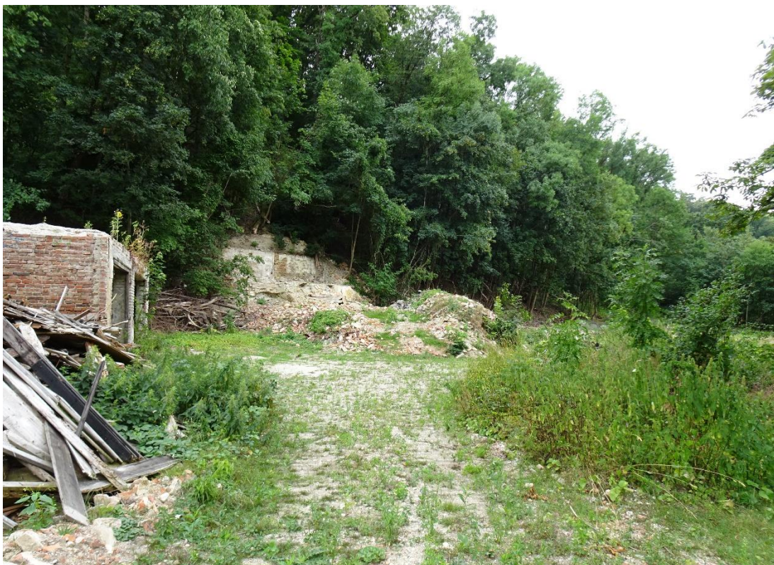
Abb. 5: Blick in Richtung Südwesten auf das UG und den noch vorhandenen Keller sowie auf die Garage (Foto: 21.07.2023)
