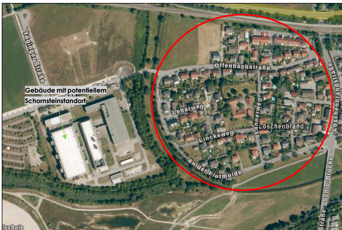
Abbildung 10: Luftbild mit Darstellung der Siedlung östlich des Plangebiets
