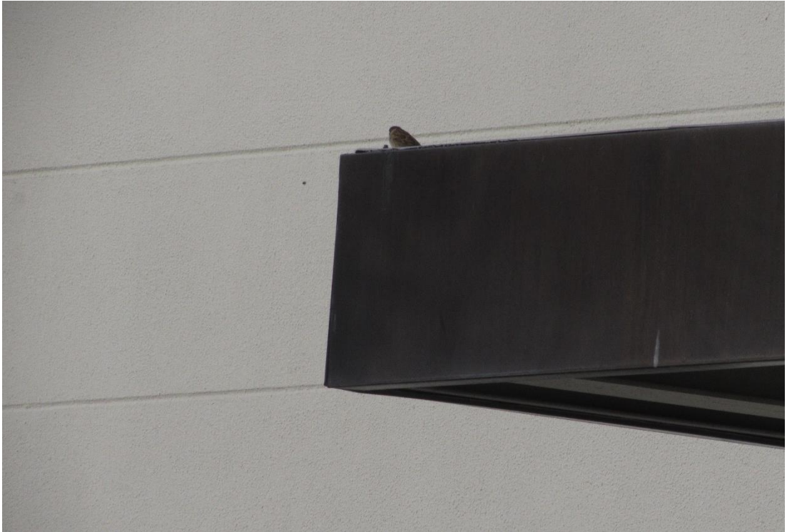
Abb. 12 Vordach am nordöstlichen Bestandsgebäude mit kleiner Brutkolonie des Feldsperlings
