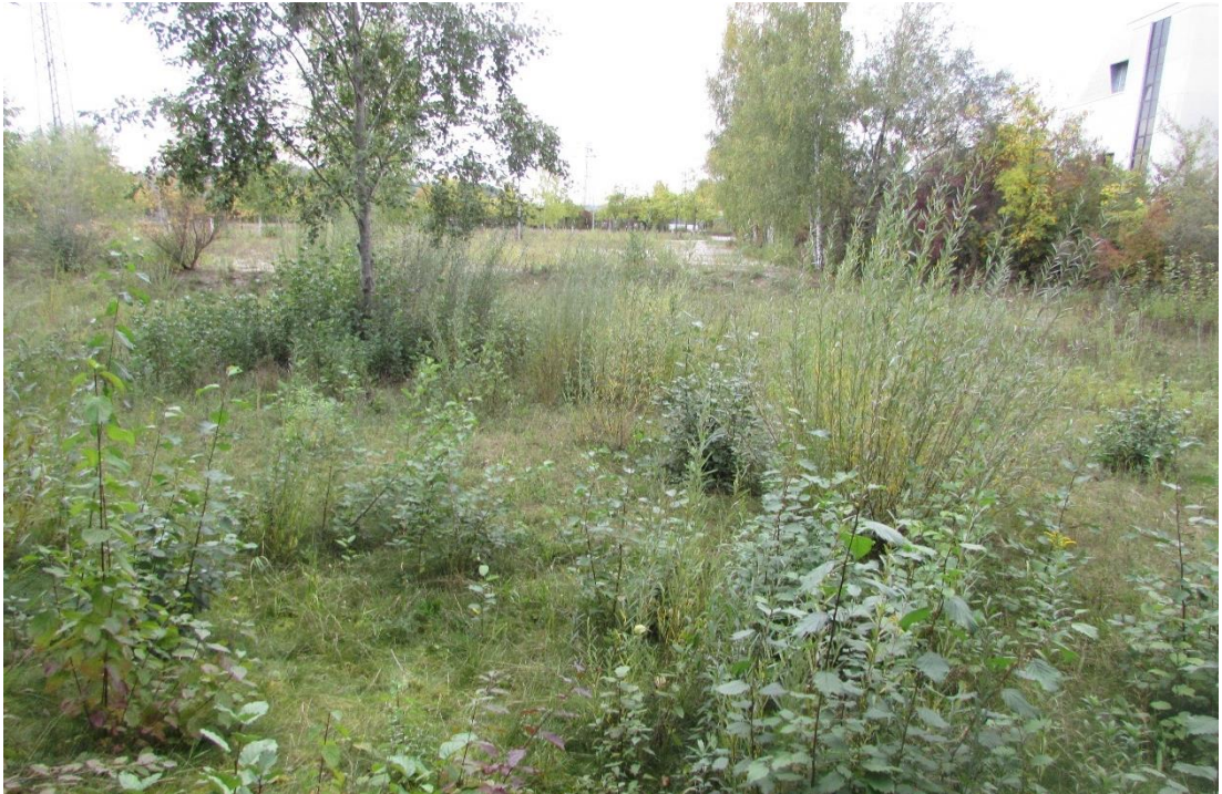
Abb. 4 Versickerungsmulde im Westen mit Verbuschung und z.T. noch lückig bewachsene Kiesrohböden
