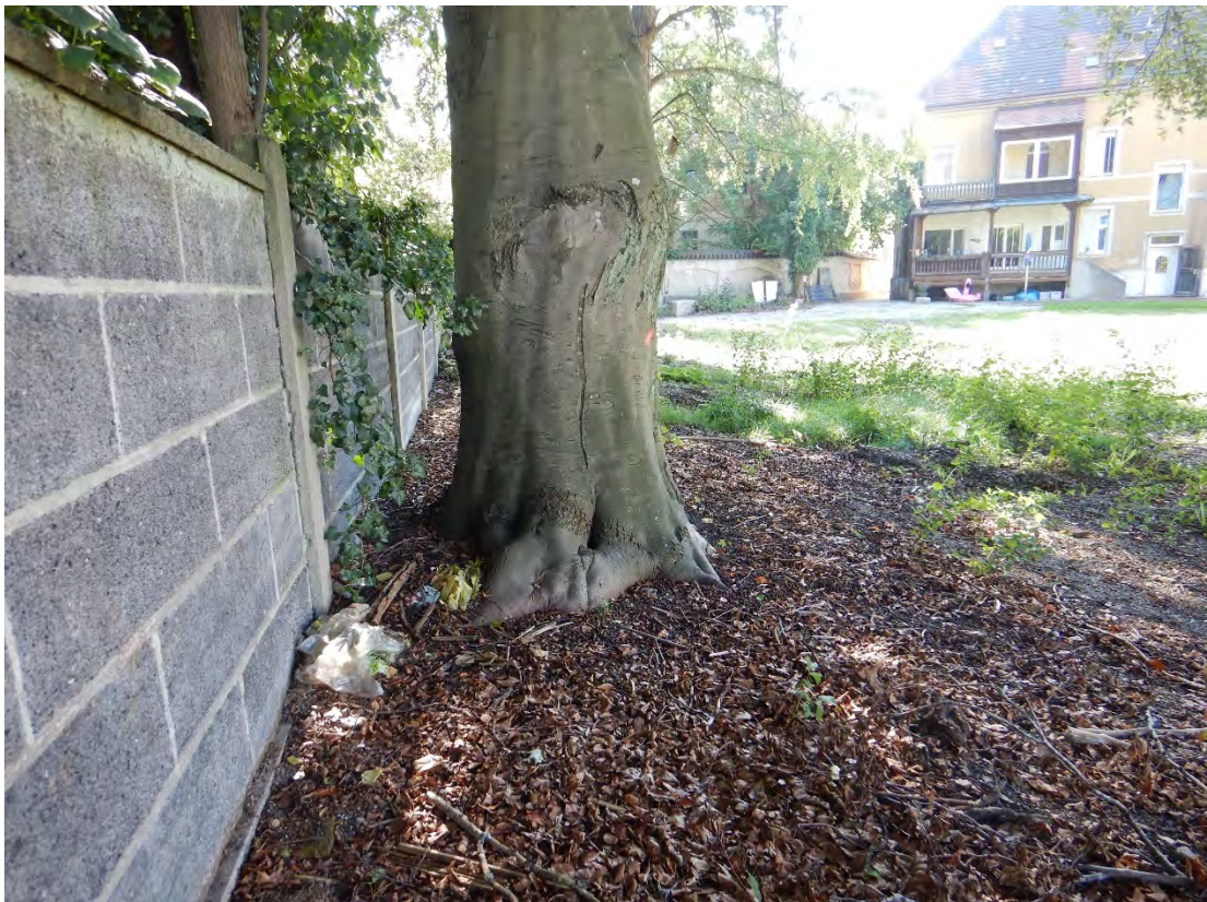
Sehr geringer Abstand zwischen Mauer und Baum 2, ältere Adventivwurzeln
