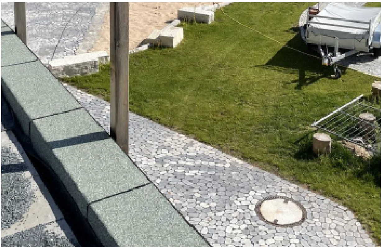
Beispiel Anschluss Kanaldeckel mit gerundetem Pflaster
