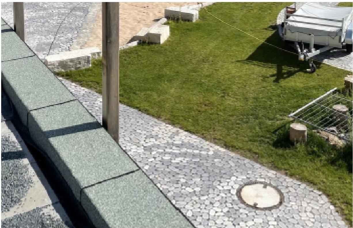
Beispiel Anschluss Kanaldeckel mit gerundetem Pflaster
