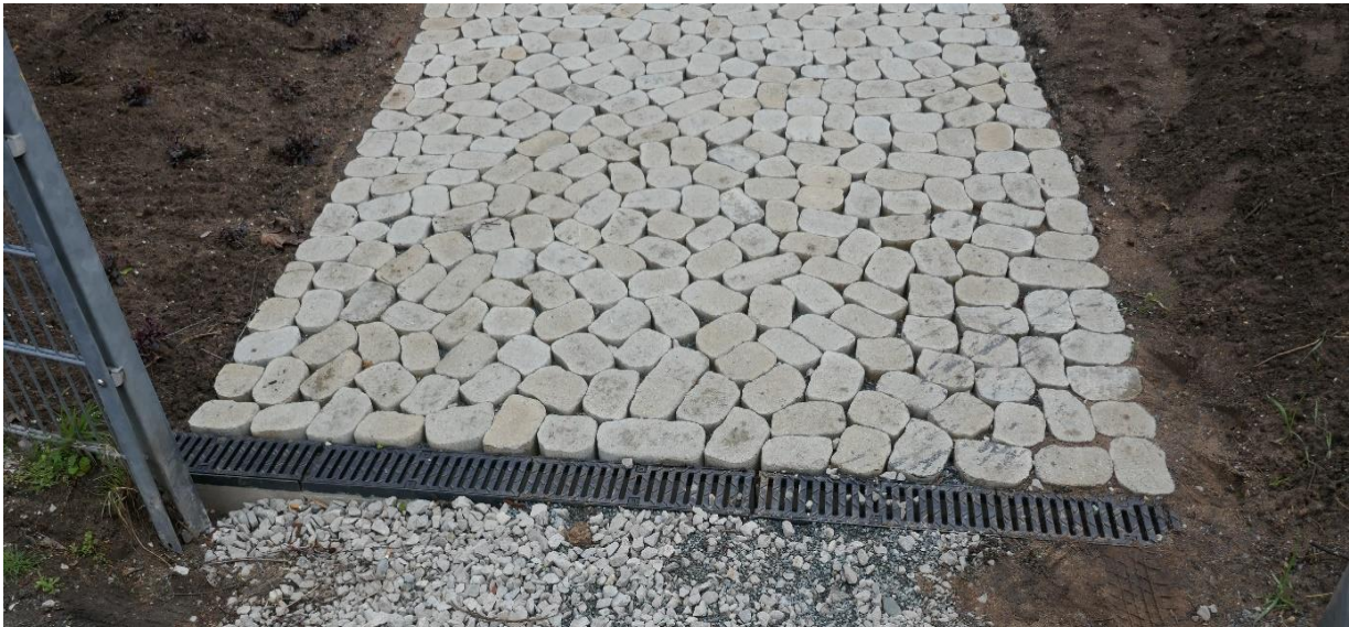
Beispiel Anschluss Rinne mit gerundetem Pflaster
