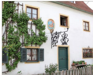
Die ehemalige Brenneisenwaage gehörte schon in früheren Zeiten zum Kloster Seligenthal. Hugo Högner hat das Haus mit viel Herzblut saniert.
