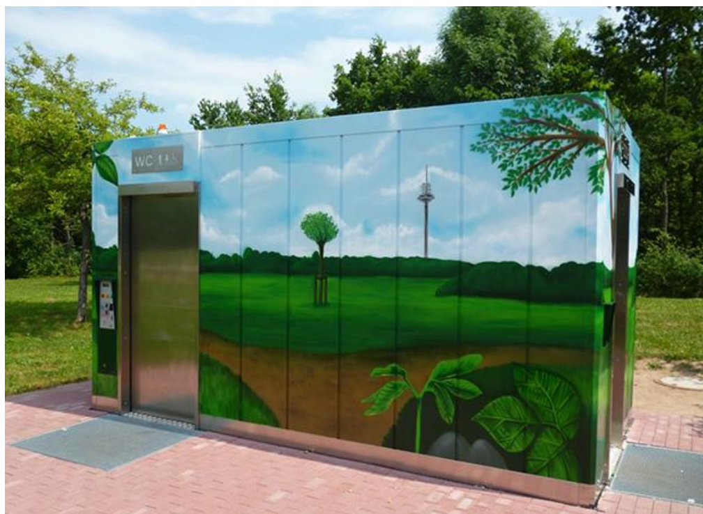
Sichtbetonfassade die mit Graffiti künstlerisch ansprechend gestaltet werden kann
