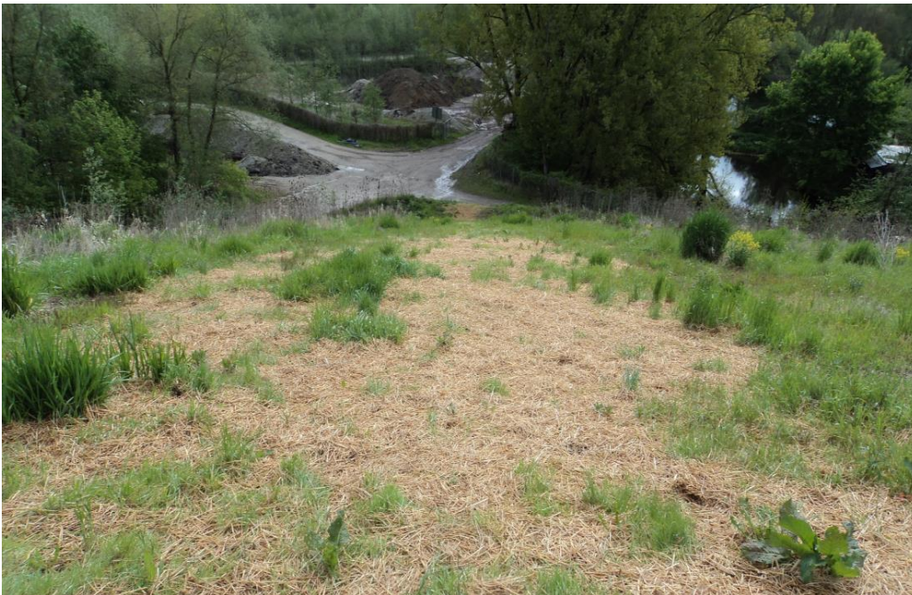
Strohschicht zur Erosionsminderung
