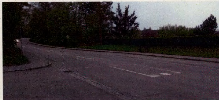
Zwei Fahrspuren, eine Abbiegespur und eine Haltebucht müssen überquert werden (Foto: Schuster)
