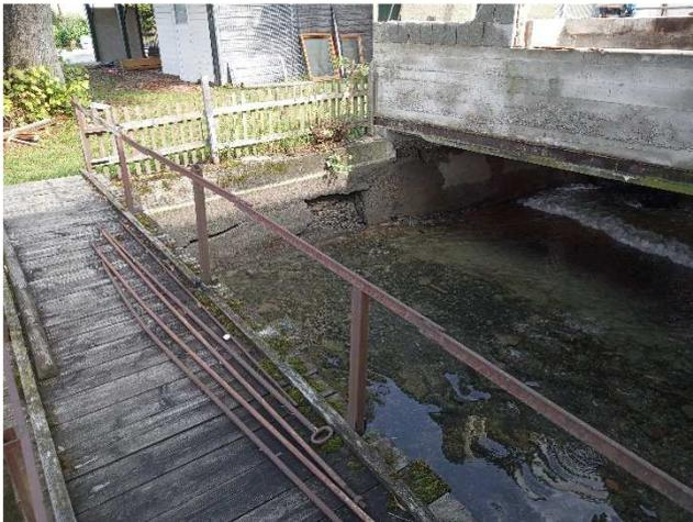
Abb. 16: Auszubessernde Stelle an Ufermauer der Wampelmühle
