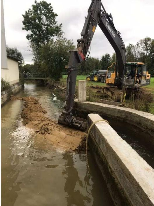
**Abb. 22: Einbringen der Lehmaufschüttung an der Bartmühle**
