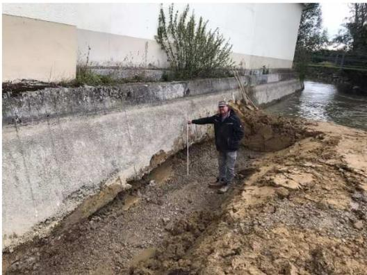
**Abb. 23: Beschädigte Mühlenmauer nach der Trockenlegung**
