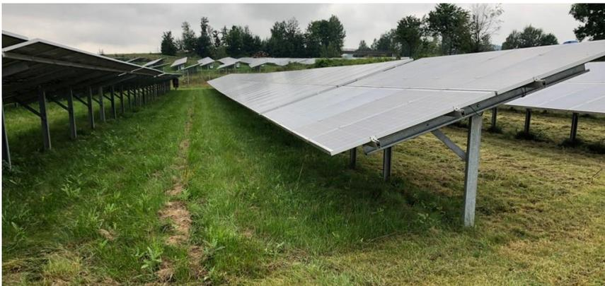
Bild-1. Aufständigung einreihig erleichtert die Mahd unter den Modulen
