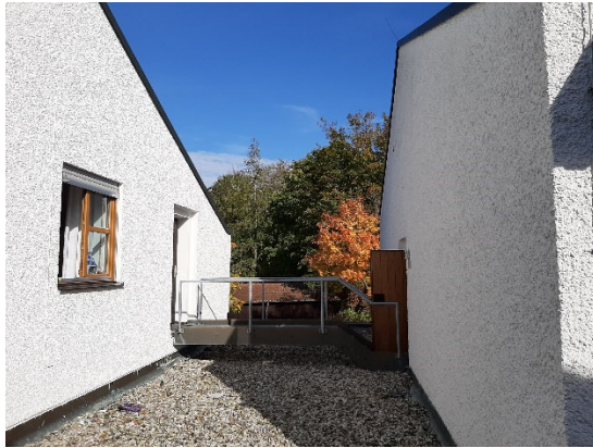
Bild 3 Bestandsverbindung zwischen Judoraum und westl. angrenzendem Gebäude
