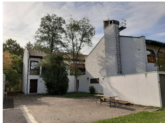
Bild 10 Rampe als seitlichen Zugang in die Turnhalle
