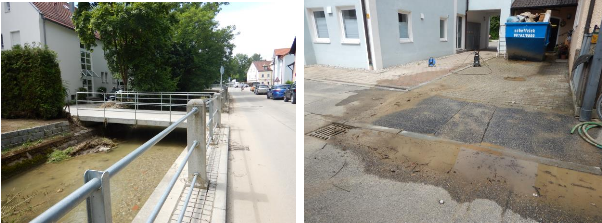
Abbildung 3.2: Roßbach mit Brücke auf Höhe Bachstraße Bachstraße 3
