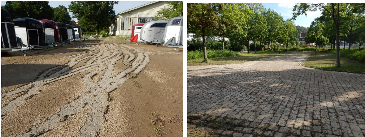
Abbildung 3.16: Parkplatzbereich bei der Ortsbegehung
