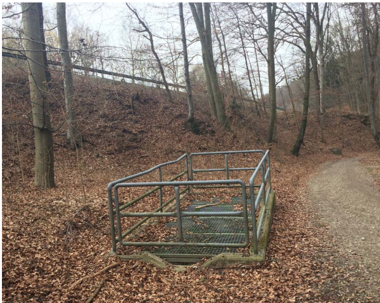
Abbildung 2.1: Auffangbecken am östlichen Wald- und Fahrradweg der B299 südlich der Bebauung von Landshut
