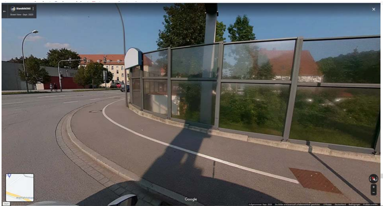
Abbildung 4.2: Schacht 12404R0101 (Quelle: Google Earth)
