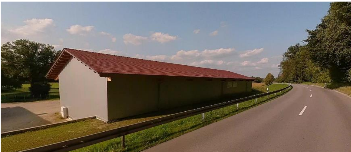
Abbildung 4.16: Maschinenhalle in Schwaig, Blick von LAs14 (Street View, Google 09/2020)
