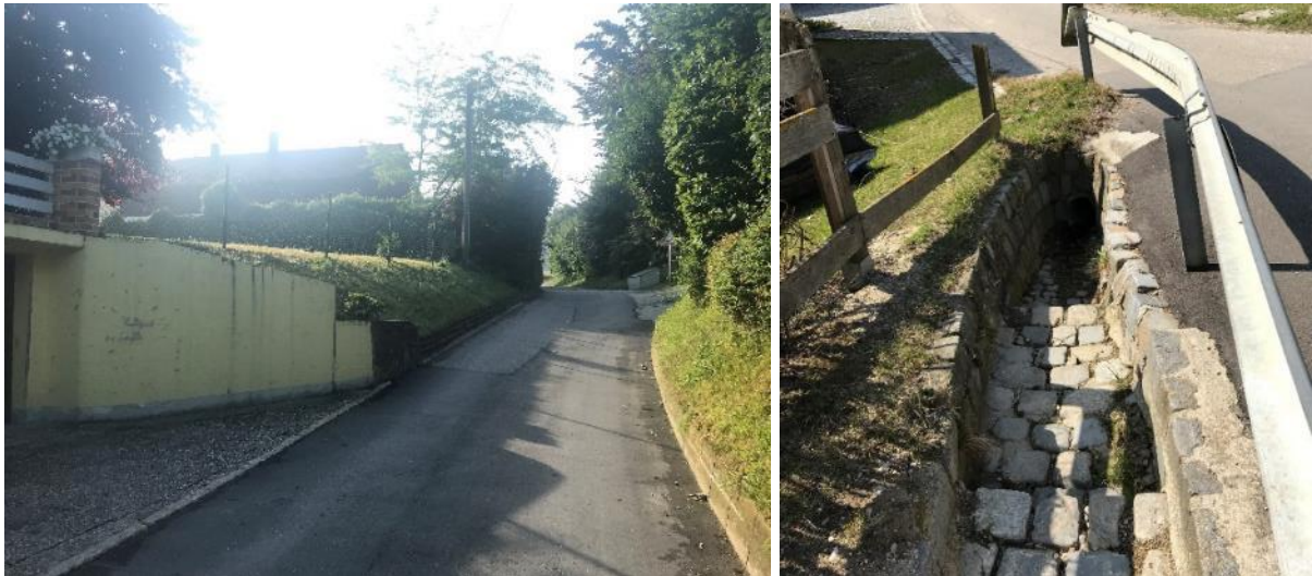
Abbildung 9.3: Fotos Ortsbegehung Stallwang, links: Garage Hsnr. 10 mit Blick Richtung Osten, rechts: Durchlass an der Stallwanger Straße
