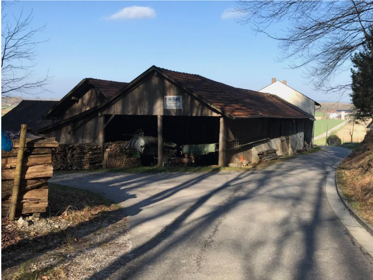
Abbildung 7.10: Lagerhalle Stockhaus Nr. 5 (Ortseingang Ost)
