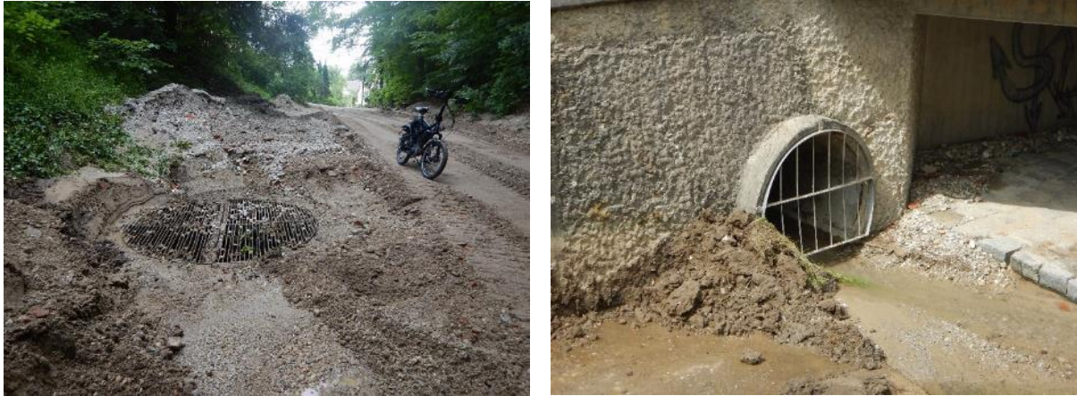
Abbildung 6.26: Kanaleinlauf Rosental (links), Kanalauslauf in den Roßbach (rechts)
