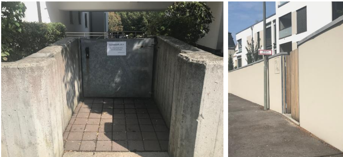
Abbildung 6.17: Hochwasserschutztüre Schönbrunner Straße 3; Ungesicherter Durchgang Schönbrunner Straße 19
