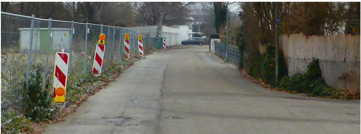
Abbildung 6: Kreuzeckweg nördlicher Abschnitt, Blick Richtung Nordost in Höhe Rotwandweg.
