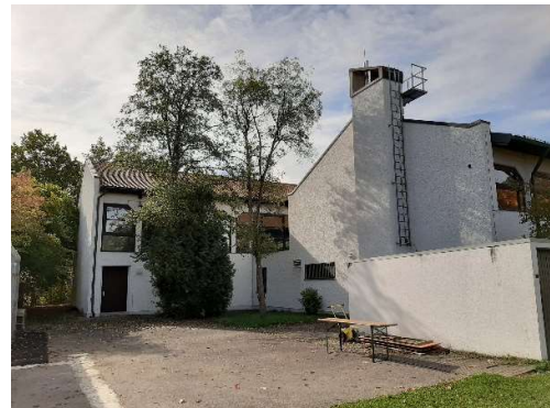
Bild 10 Rampe als seitlichen Zugang in die Turnhalle
