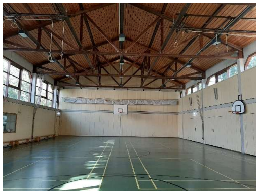
Bild 1 Zustand Turnhalle Bestand
