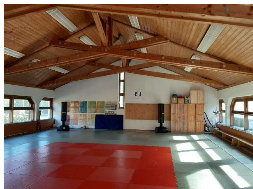
Bild 2 Zustand Judoraum Bestand
