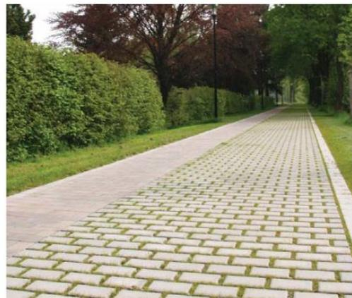
**Abb. 16** (Rasenfugenpflaster auf wenig befahrenem Fahrweg; Quelle wie Abb. 14)
