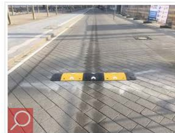
Am Mannesmannufer sind jetzt neue, nun fünf Zentimeter hohe Schwellen installiert worden, um Rasern und der "Poserszene" zu begegnen; Foto: Landeshauptstadt Düsseldorf
