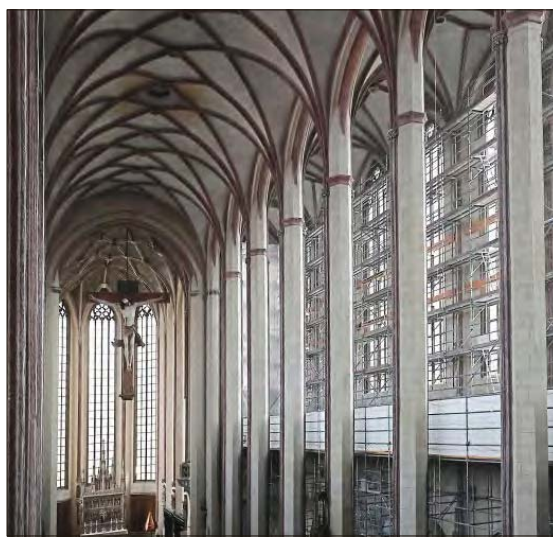
Die Sanierung wird in drei Bauabschnitten vorantasten gehen und soll bis Ende 2026 beendet sein. Foto: LZ-Archiv/cv
