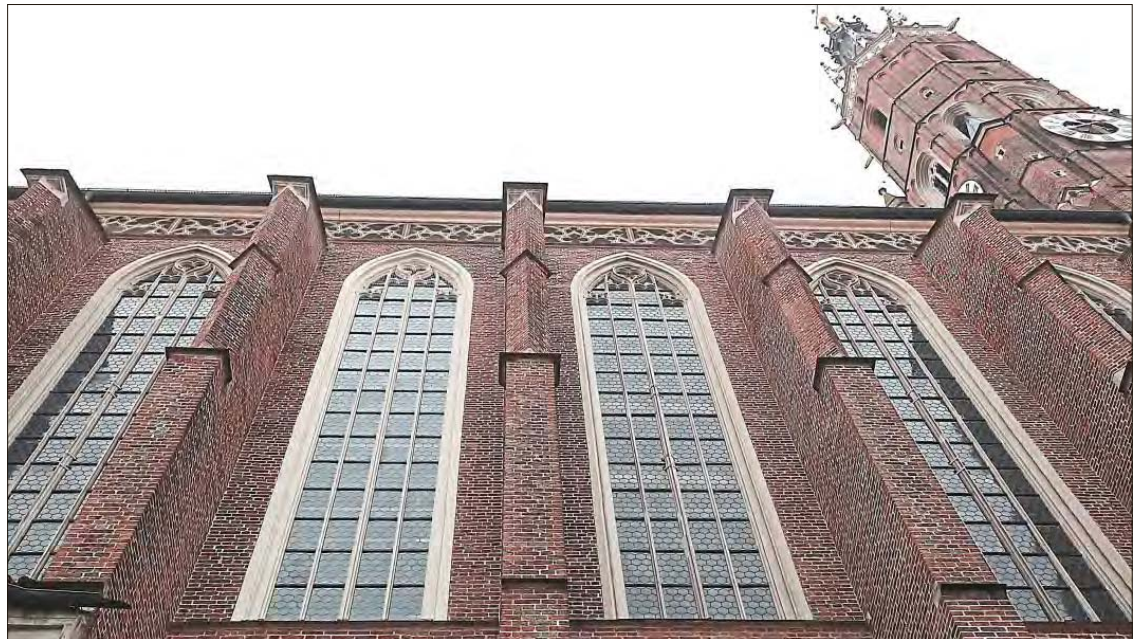
So wie das zweite Fenster von links sollen in knapp sechs Jahren auch die übrigen 28 Fenster der Martinskirche aussehen. Das Fenster auf der Nordseite wurde vor gut zwei Jahren als erstes „Musterfenster“ exemplarisch saniert, um weitere Erkenntnisse zum Schadensumfang zu sammeln. Fotos: Christine Vinçon
