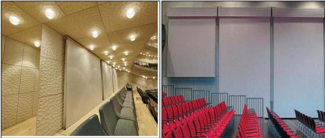
Abbildung: Beispiel für variable Absorptionsmaßnahmen „G-Sorber“ der Fa. Gerriets
