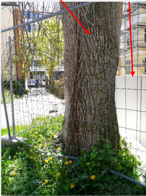
Abb. 5 Stamm und Stützwand
