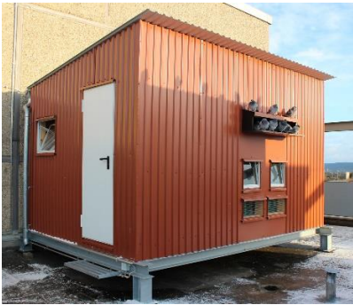
Taubenhaus Flachdach Jena
