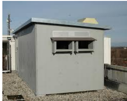
Taubenhaus Flachdach München
