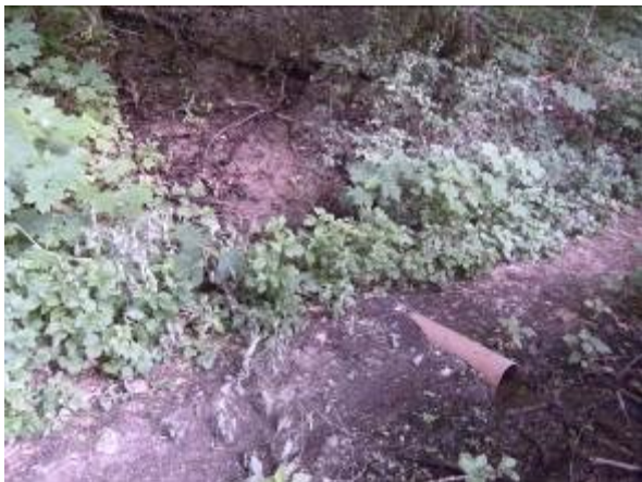
Verrohrtes Quellrinnsal unter Weg
