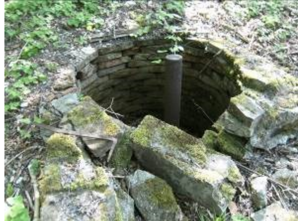
Rest einer gemauerten Brunnstube (aktuell trocken)
