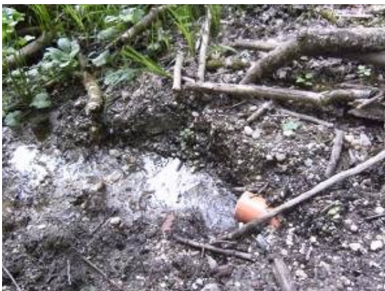
Verrohrter Quellbach im Bereich des Gehwegs
