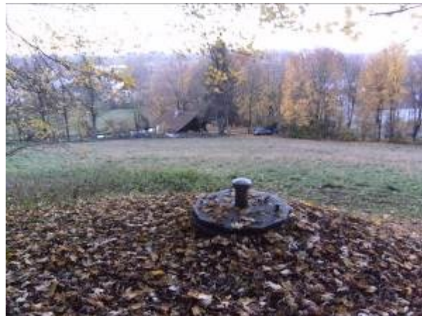
Brunnstube mit „Entenhäuschen“ im Hintergrund
