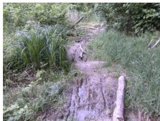
Trittschäden im Bereich des Gehwegs
