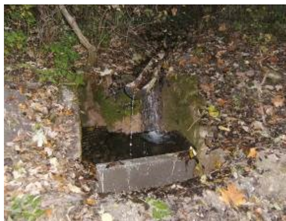
Kurz nach der Sanierung
