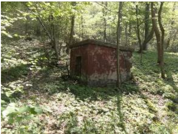
Brunnenhäuschen mit Brunnstube
