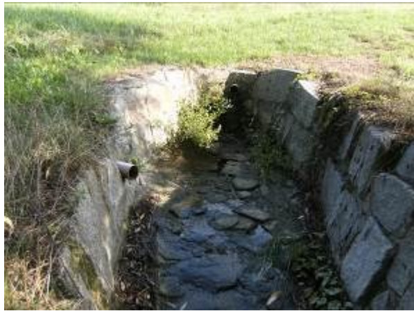
Austritt des Quellbachs unterhalb der Verrohrung
