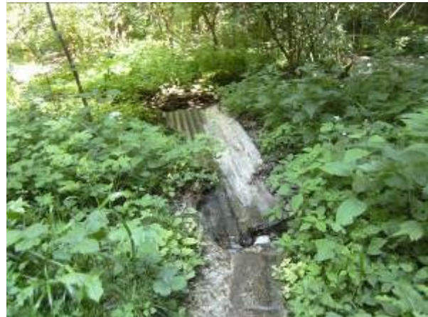
Quellbach nach Querung des Gehwegs
